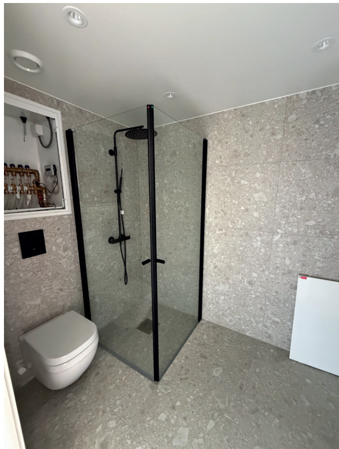
Det er benyttet baderomskabiner i utbyggingen.
