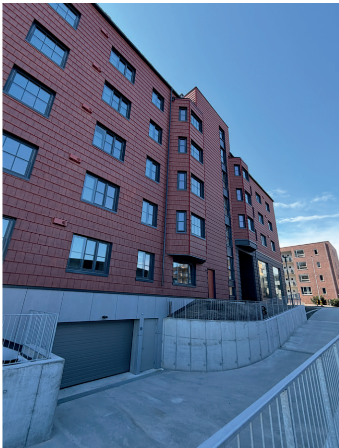
Nedkjøring til parkeringskjeller.
