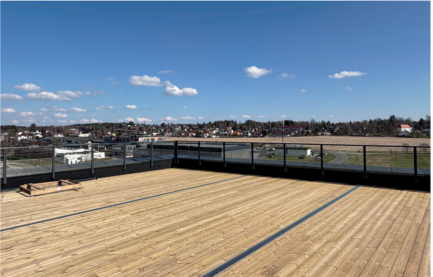
Store arealer på takterrassen.
